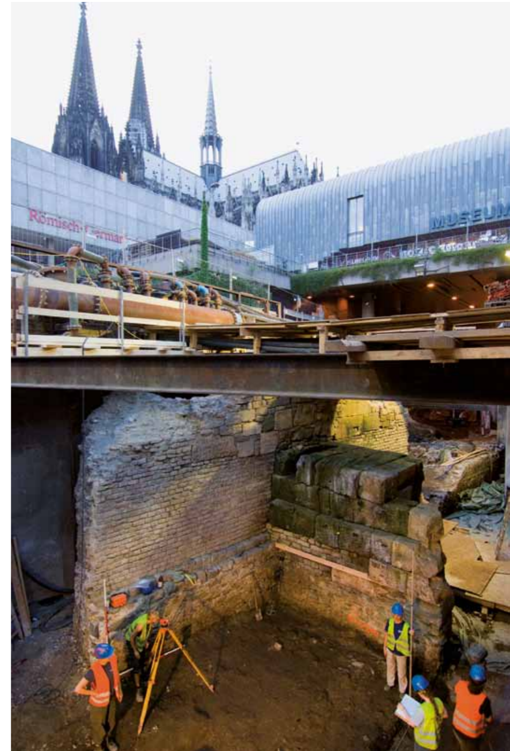
Kurt-Hackenberg-Platz. Blick in die Baugrube mit der römischen Stadtmauer und dem Abwasserkanal unter dem zugemauerten Hafentor.
